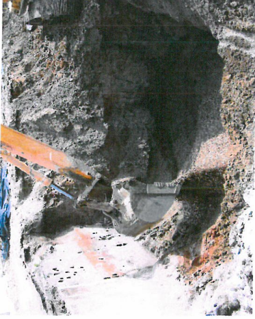
11-Remblaiement par graves autoblocantes
