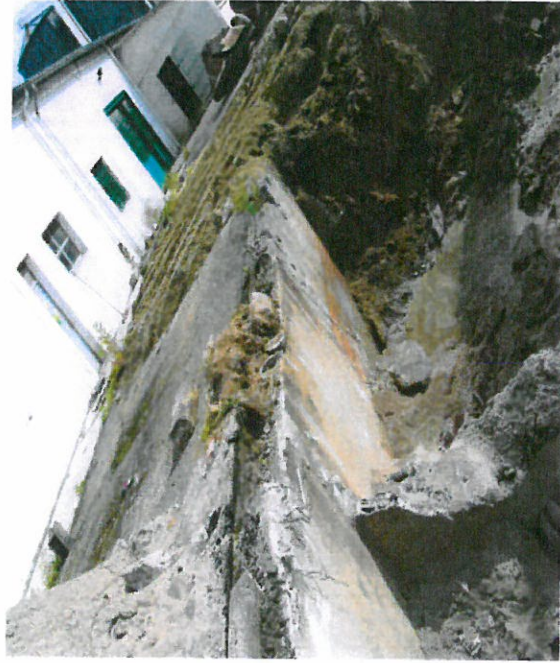
2-Excavation côté garage
