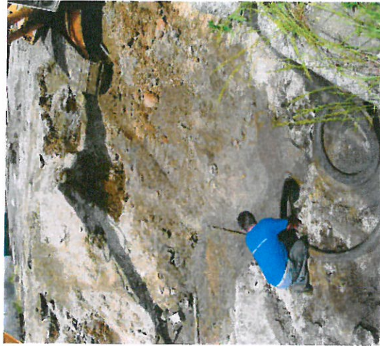
8-Vidange fond de fouille/phase flottante
