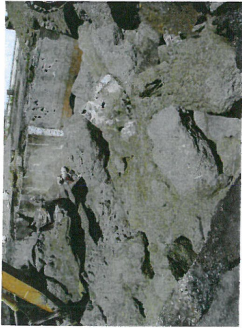
1-Extraction terres non souillées
