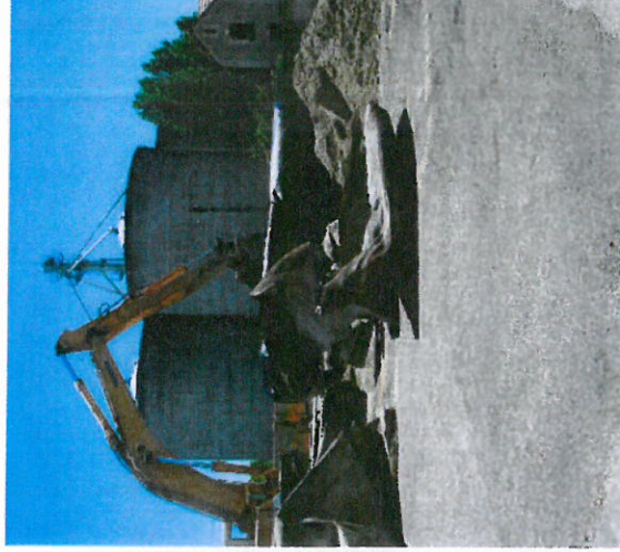
4-Extraction cuves après inertage, dégazage et hydrodécoupe
